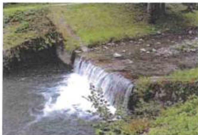
Seuil le long du Morel afin de ralentir son débit
